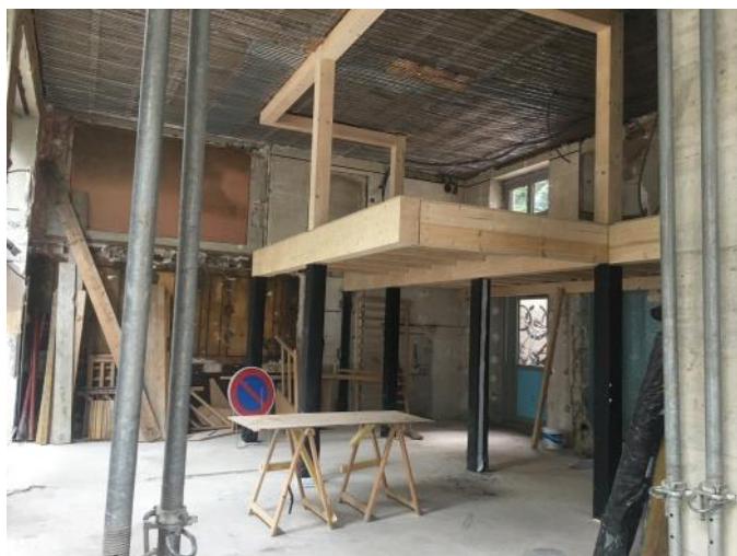
Volume intérieur dégagé, mezzanine en construction
